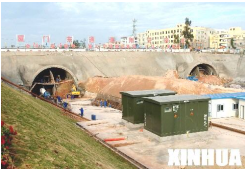
(c) 中国大陆第一条大断面海底隧道施工进度顺利
