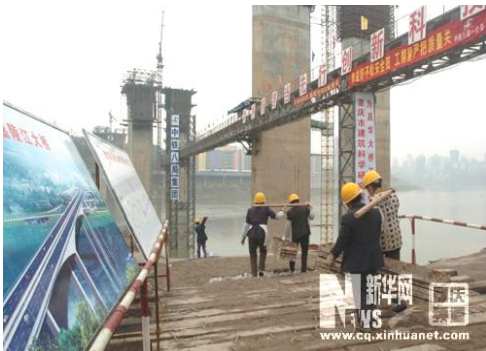
(d) 重庆嘉华大桥进入桥面施工 预定 07 年底开通
