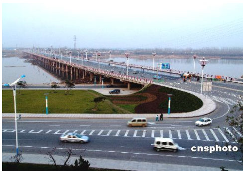
(a) 长江以北最宽的桥梁山东临沂沭河大桥竣工通车
